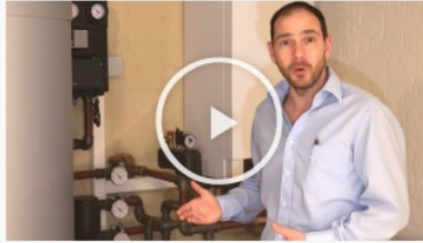
Worauf beim Heizungsersatz zu achten ist
